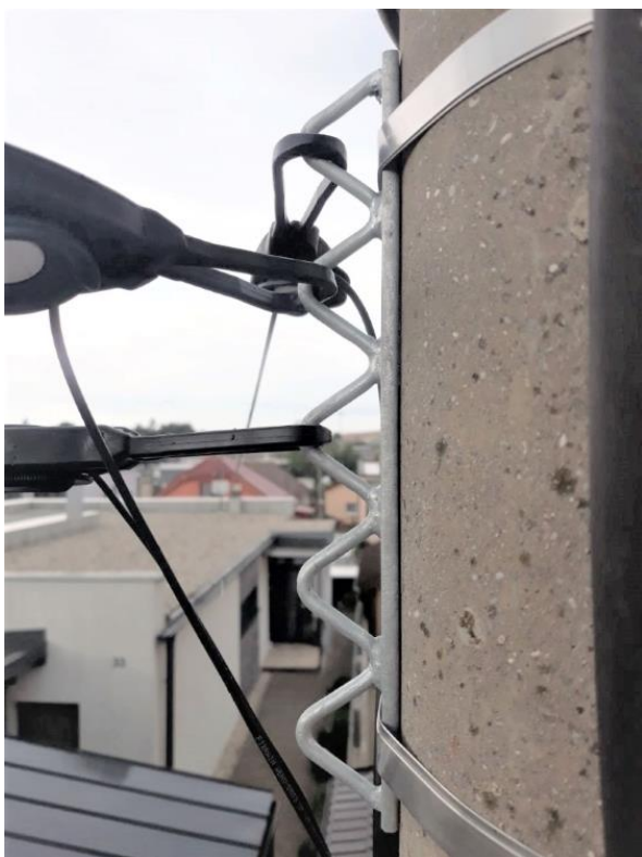
kotvenie káblov na stĺp aplikácia DNK250 , KPRU16 TWIN a pásy Bandimex
